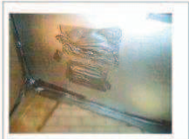
Foto 4: Foliewand en verwijderd plaatmateriaal
