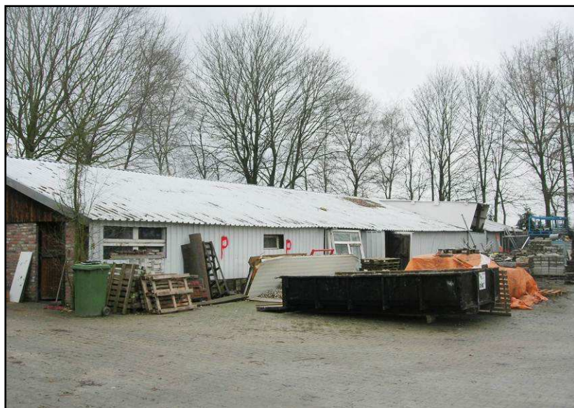
Figuur 30: Bestaande, te slopen loods
