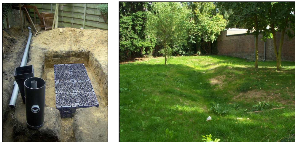
Figuur 20: Voorbeelden van infiltratiemogelijkheden
