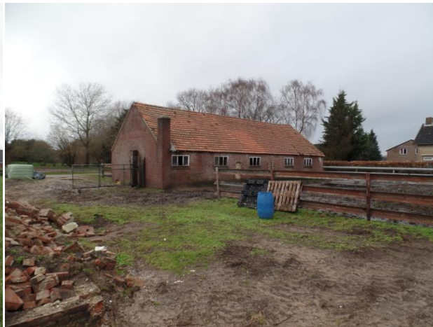
Fig.3 Stalgebouw op locatie Laarbroek 9
