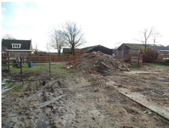
Fig.4 Puinhopen en fundament Laarbroek 9
