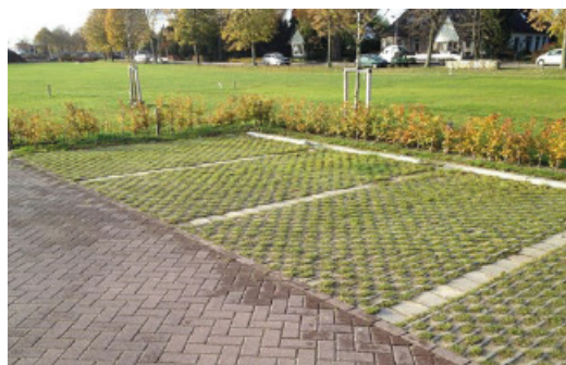
Parkeren op grasbetonstenen. Het gras groeit tussen de stenen en geeft een groen aanzicht op tijden waarop niet geparkeerd wordt.
