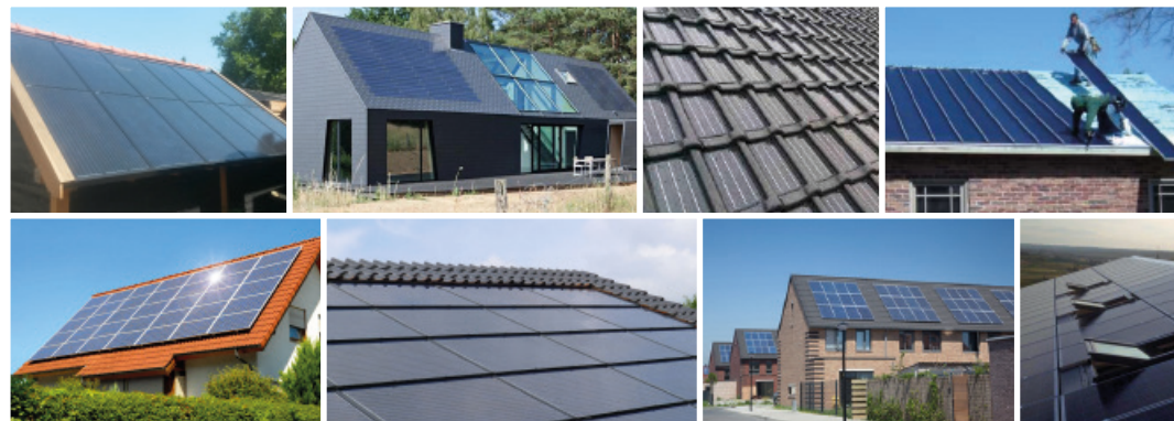
Referenties van zonnepanelen op dakvlakken.
