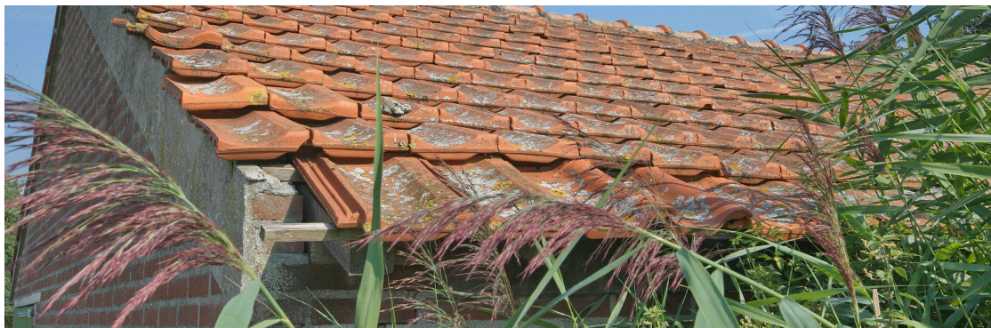
Figuur 8: Achterzijde pannendak schuur.
