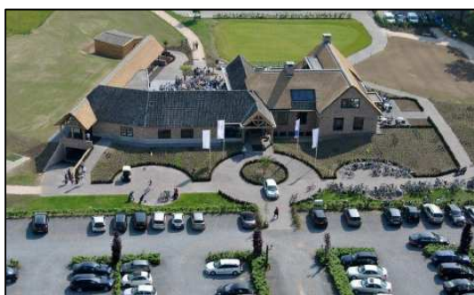
Foto 1. Bestaande clubhuis binnen plangebied
