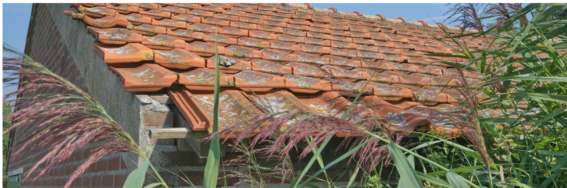
Figuur 8: Achterzijde pannendak schuur.
