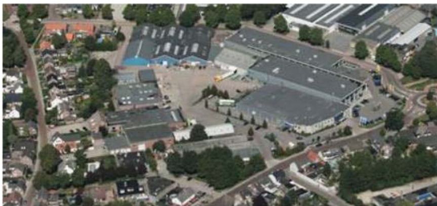
Luchtfoto bestaande situatie
