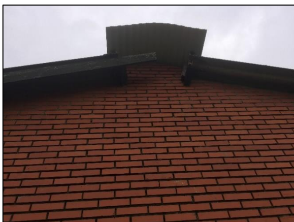
Foto 3. Dak van stal die gesloopt wordt
