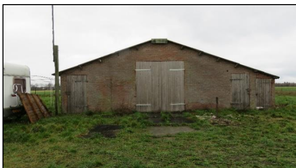
Foto 7: Schuur aan de westzijde van de Ooruilweg
