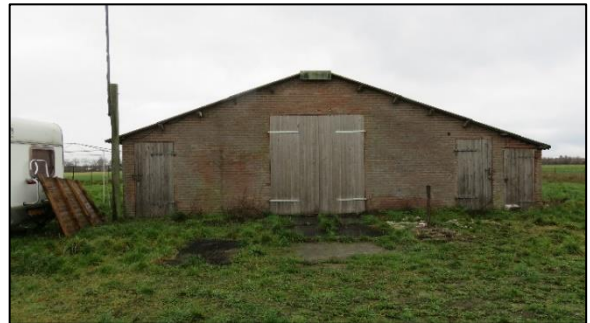
Foto 2. Schuur aan de westzijde van de Ooruilweg
