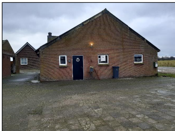
Foto 5: te slopen bijgebouw
