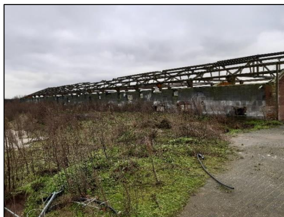
Foto 2: Eén van de deels gesloopte stallen
