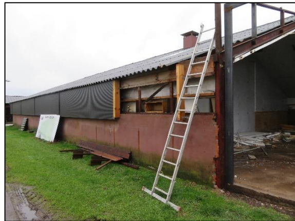
Foto 2. Buitenkant van de meest westelijk gelegen stal die in verbouwing is
