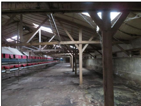
Foto 5. Binnenkant van de middelste voormalige kippenstal
