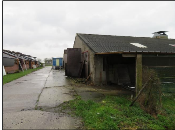
Foto 4. Meest noordelijk gelegen oude kippenstal gezien vanuit het noordoosten van het plangebied
