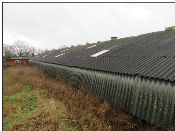
Foto 6. Buitenkant van de middelste kippenstal gezien vanuit het oosten
