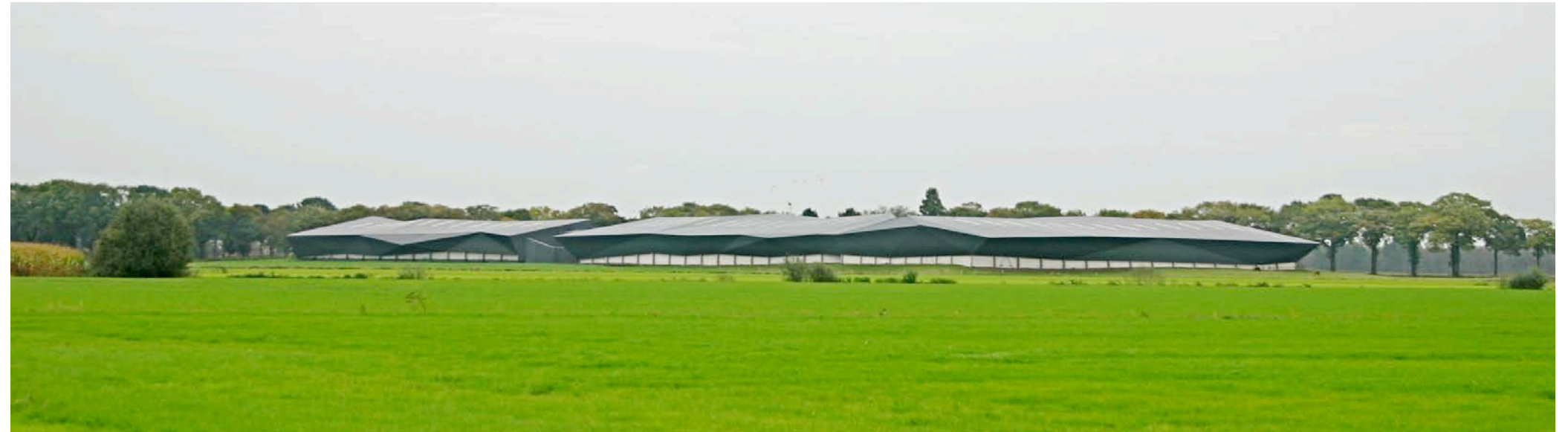
Het ritme in de plint is momenteel van betekenis als indicator voor de maat en schaal van het gebouw
