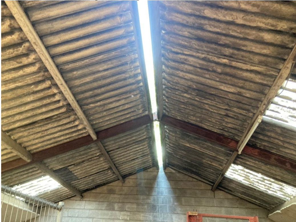
• Afbeelding 12: nok stal ongeïsoleerd
