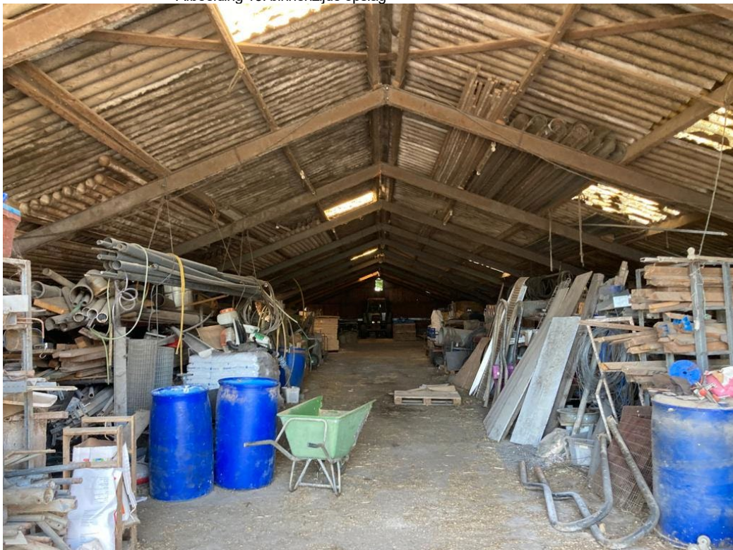
• Afbeelding 13: binnenzijde opslag
