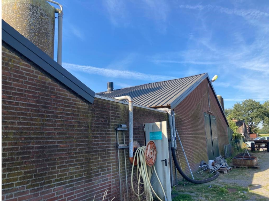
• Afbeelding 16: aanzicht achterzijde te slopen stallen
