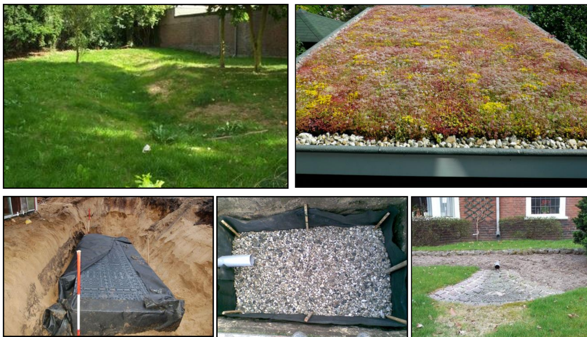
Figuur 17: Voorbeelden infiltratievoorzieningen
