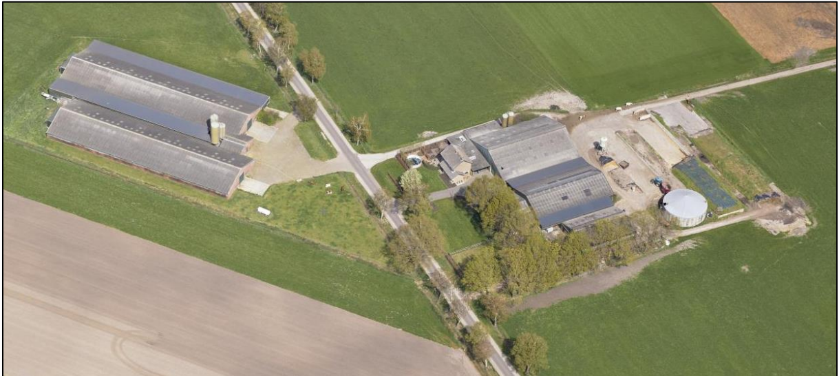
Afbeelding 4. Luchtfoto huidige situatie plangebied.
