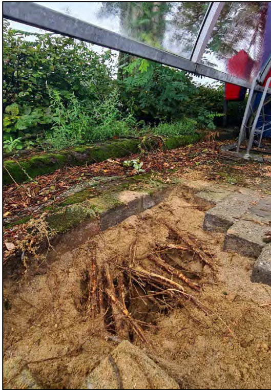
Afbeelding 11: Boom 10 wortelt intensief onder de verharding.
