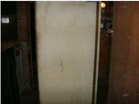
Foto 12. Asbestvrij brandwerend deurbeplating cv ruimte in gebouw D
