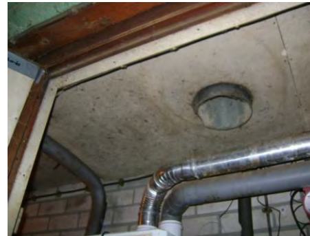
Foto 14. Asbestvrij brandwerend plafond in cv ruimte gebouw D
