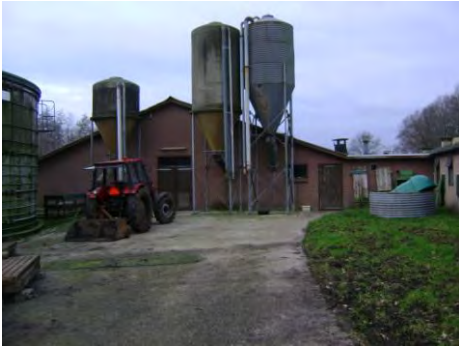
Foto 11. Asbesthoudend golfplaten dak gebouw D.
