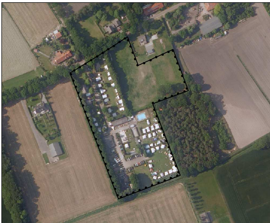
Figuur 4: Luchtfoto camping
